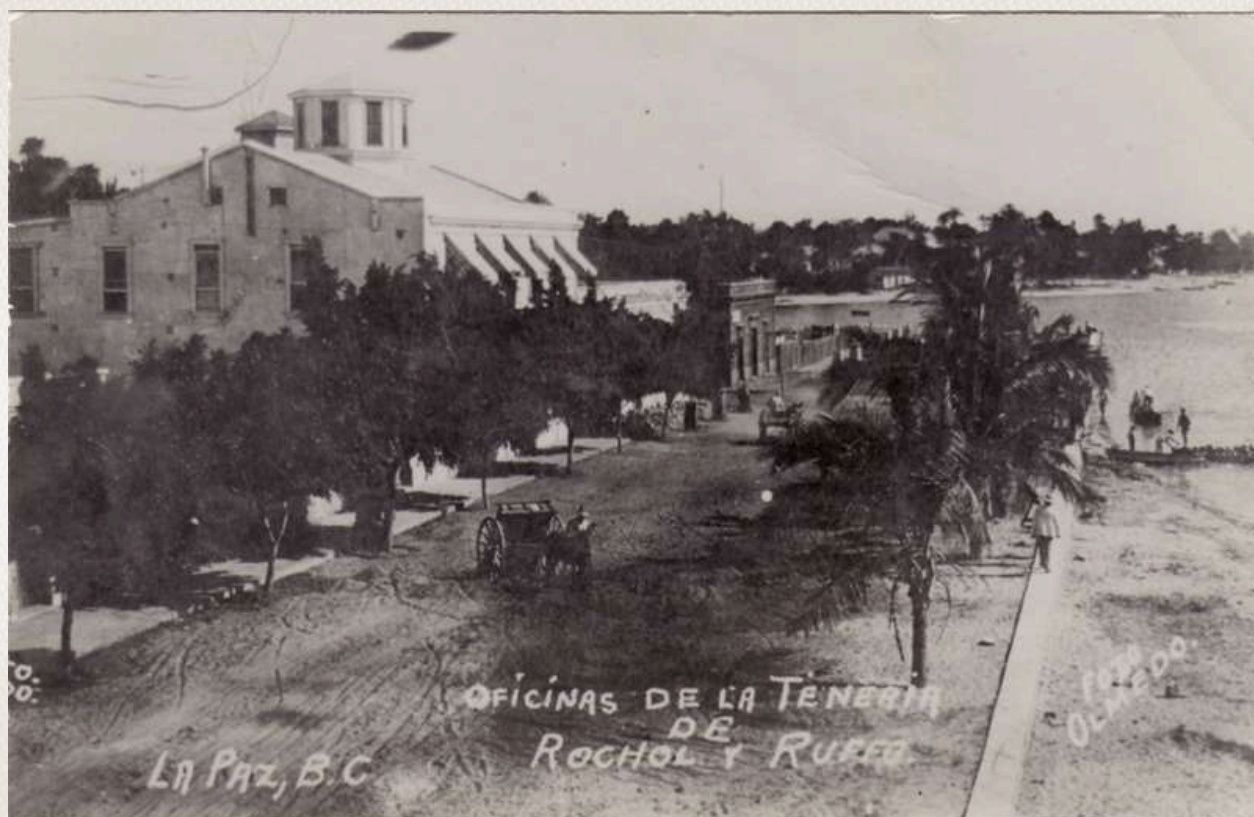
* Panorámica de las oficinas de la Tenería Suela Viosca de Rocholl y Ruffo
